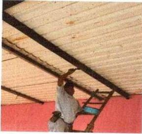
Foto 1: MANTENIMIENTO DE COSTANERAS DE METAL
